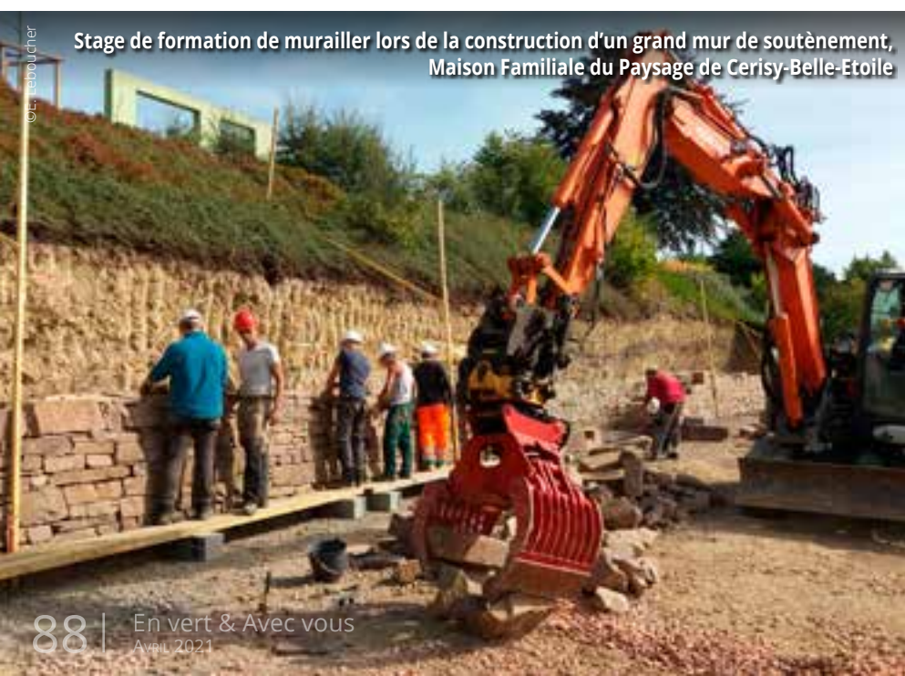
Réfection d'un muret permettant de rattraper le dénivelé du terrain
