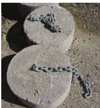
◀ Ancrage en béton pour les modules végétalisés
