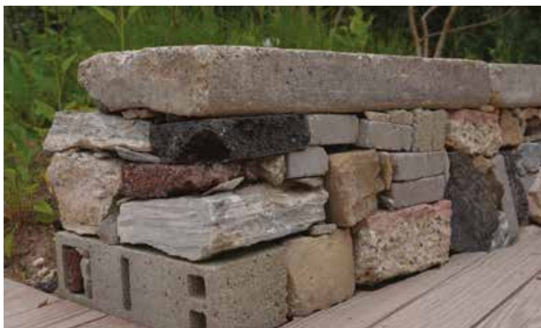
"Jardin Polémoflore", banc composé de matériaux de réemploi assemblés selon la technique de la pierre sèche
